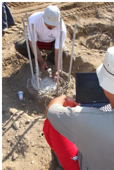
Сеизмометријско тестирање шипова на грађевинском објекту (Београд)
